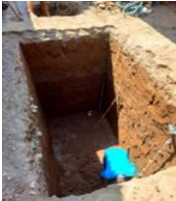
Gambar 2. 8 Pembangunan SPALDS Individual dan Komunal
