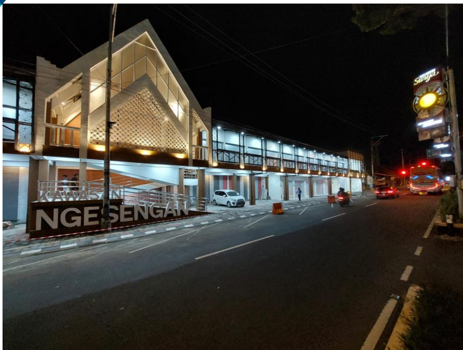
Gambar 2. 9 Pembangunan Shelter Ngesengan
