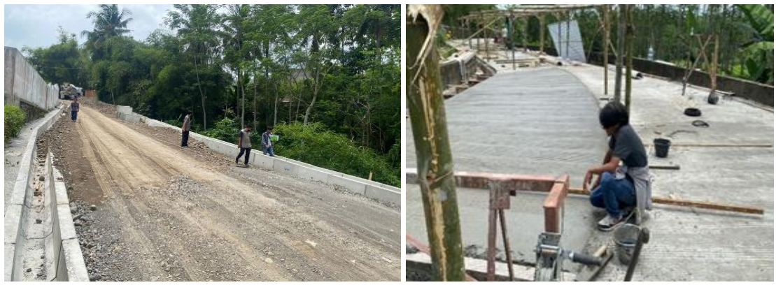
Gambar 2. 7 Kegiatan Fisik Peningkatan Jalan Menuju Lokasi Rencana Dibangunnya TPST Bojong
